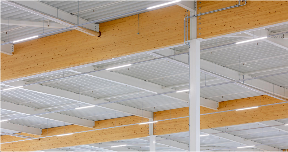
Dakconstructie van staal met houten spanten bij Virgo Aalsmeer
