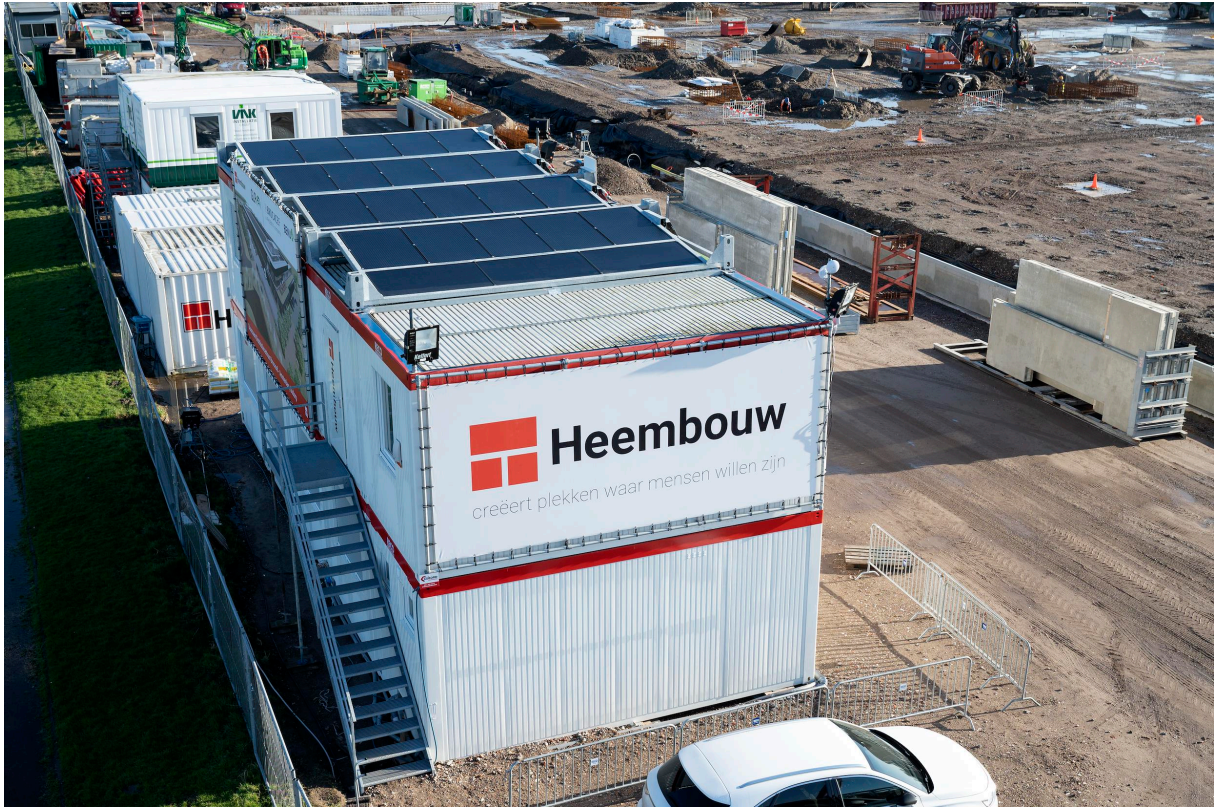
Zonnepanelensets op het ketenpark zorgt voor reductie emissie op de bouwplaats
